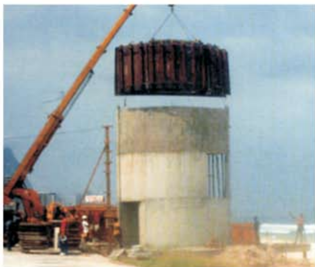
Obra: Rio Orla - RJ Construtora FERCON
