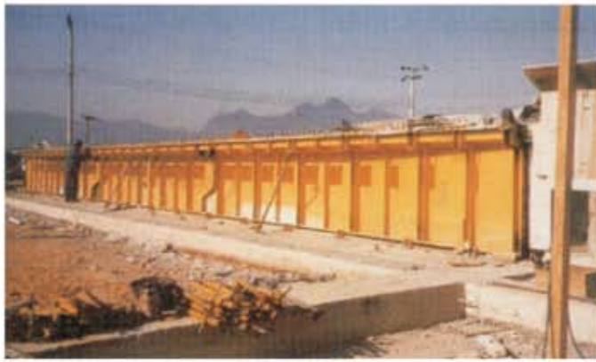
Obra: Linha Vermelha - RJ Construtora Carioca Engenharia
