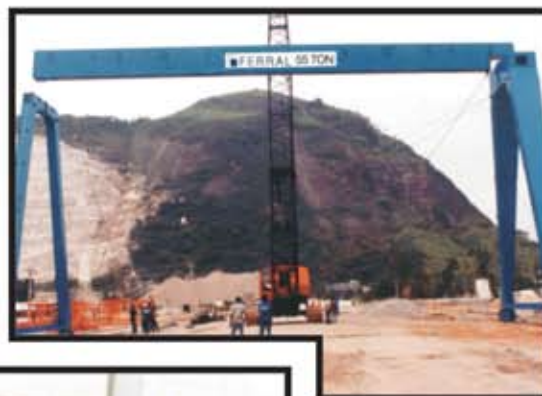
Pórtico Rolante 55t x 25m (fase de montagem)
