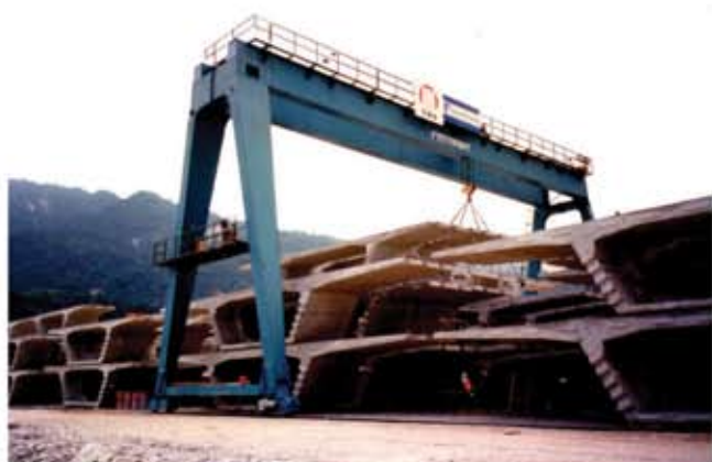
Portico - Cap. 55 ton / 25 m de vão para movimentação das aduelas pré-moldadas
