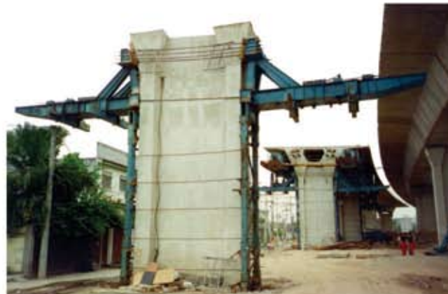
Montagem típica de conjunto de "Pier brackets" em pilar existente
