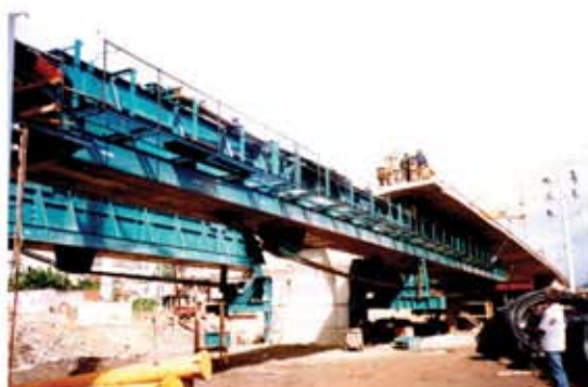
Lançamento de aduelas sobre as vigas metálicas pré-tencionadas
